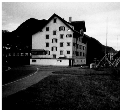
Bild 6: Abbruch des Waisenhauses 1988
