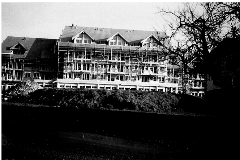
Bild 5: Bau Alterswohnheim Buochs 1988-1990
